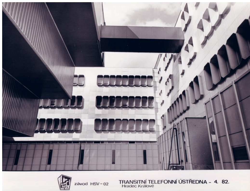
4. Neznámý fotograf, Radiační plášť administrativně-provozní budovy TTÚ, duben 1982, zdroj: SOA HK, Pozemní stavby, s. p. Hradec Králové, karton 89, Fotodokumentace o činnosti podniku.
