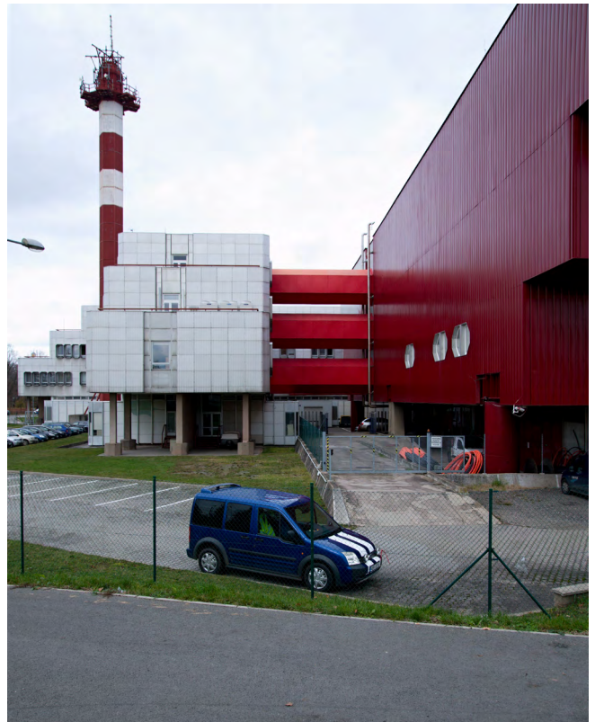
2. Tranzitní telefonní ústředna v Hradci Králové, spojovací koridor mezi sociálně-administrativní a technologickou budovou, foto: Jakub Potůček 2020.
