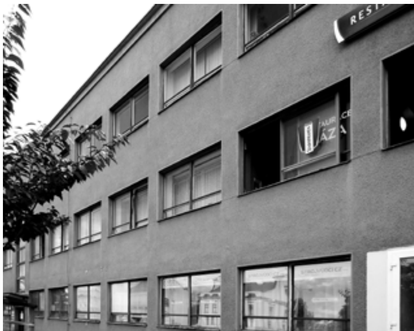
Obr. 11 Okna Cristal před výměnou v budově smíchovského nádraží, kolem roku 2017. Foto Jakub Potůček
