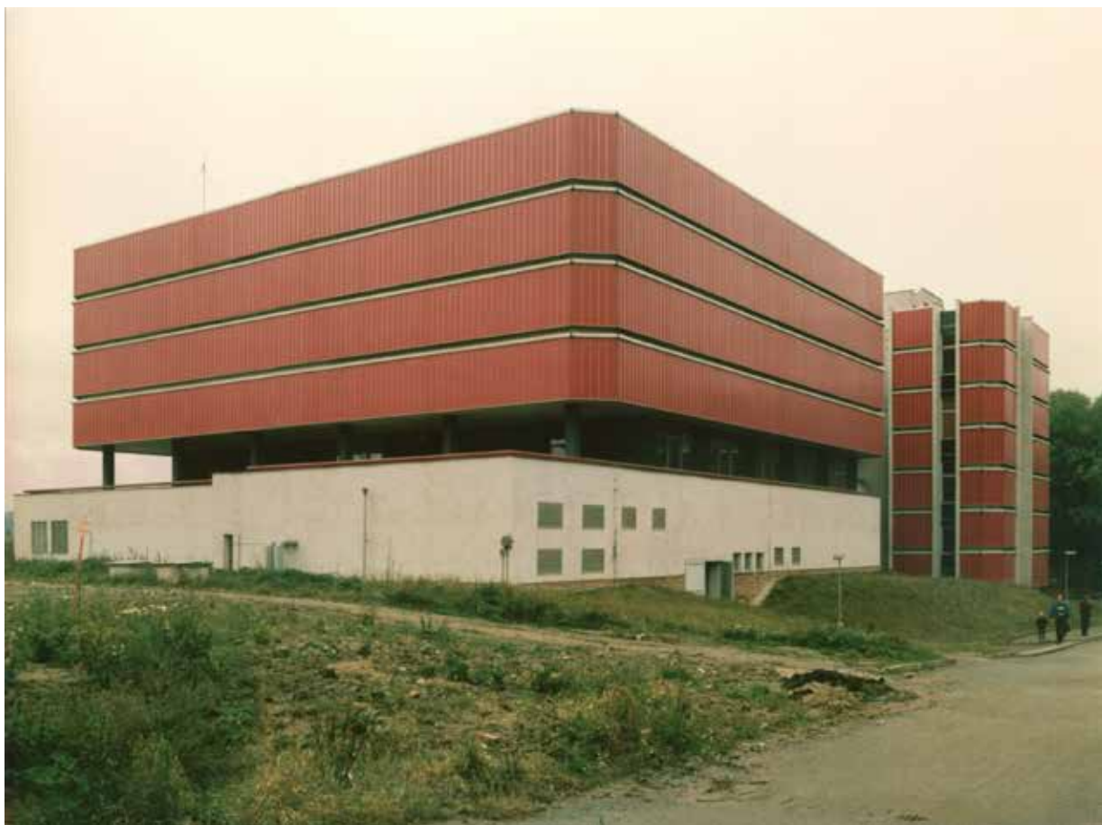
Automatická telefonní ústředna v České Lípě (1979–1984), Jindřich Malátek, Jiří Eisenreich, Ivo Loos, Václav Aulický, Václav Mašek, Spojprojekt Praha, Archiv Jaroslava Zemana
